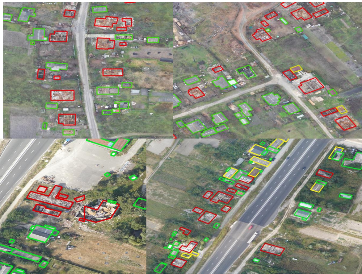
Рисунок 4.3.1 Приклади застосування підходу. Зелений колір - рівень руйнування 1, жовтий колір - рівень руйнування 2, червоний колір - рівень руйнування 3.
